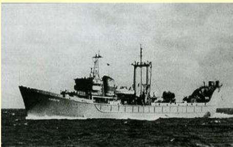
**24 декабря 1964 года** в Николаеве на судостроительном заводе им. 61 коммунара спущено на воду спасательное судно «Карпаты» водоизмещением 5600 тн. для спасения личного состава и подъема аварийных подводных лодок с глубин до 300 м.
