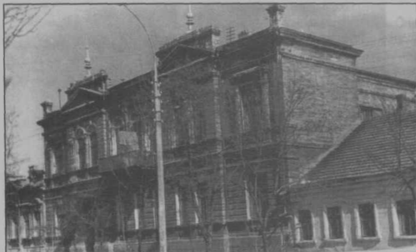
Старый дом на Католической улице. Современный вид.
