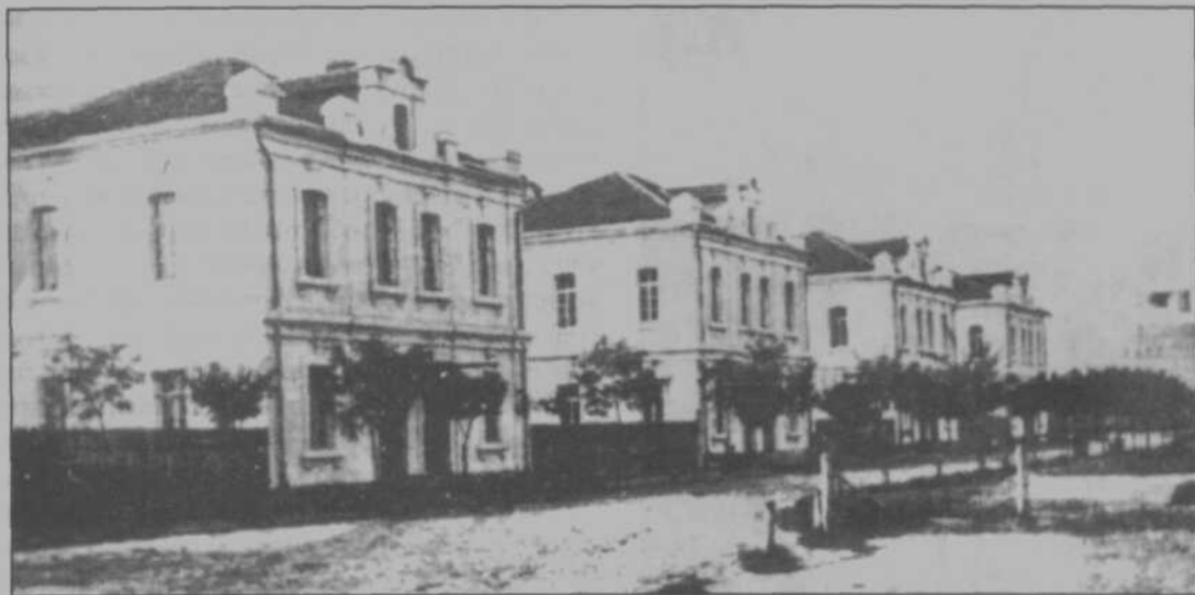
Жилые дома инженерно-технических работников завода "Наваль" на Заводской улице. Из каталога завода.
