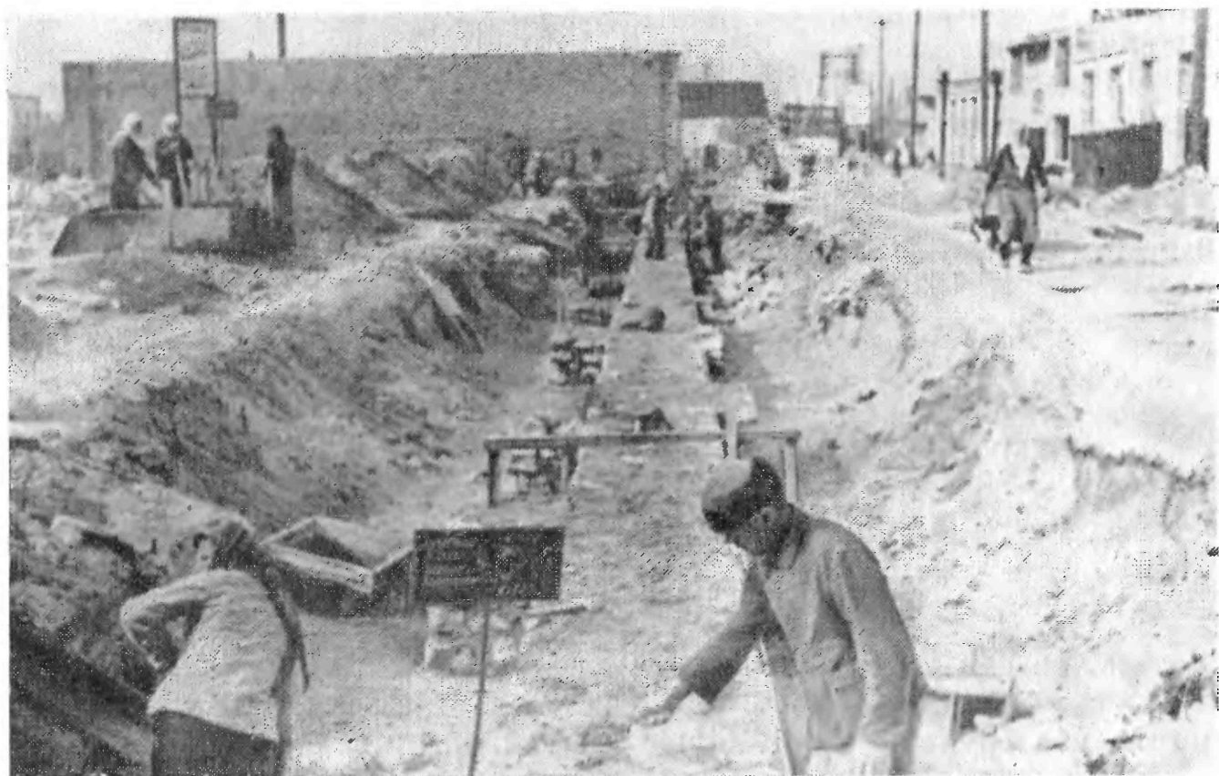
Работы по восстановлению Черноморского судостроительного завода. 1945 г.
