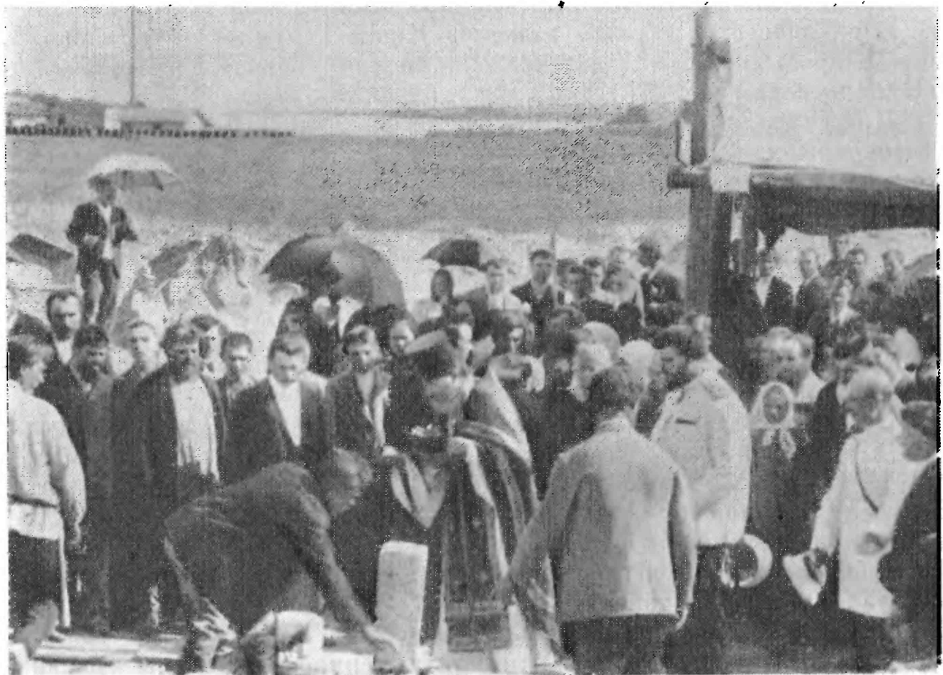
Закладка завода «Наваль». 1895 г.
