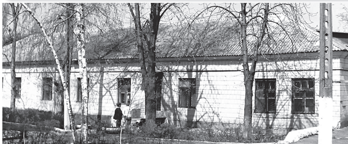
Корпуса Николаевской еврейской больницы по ул. Садовой
