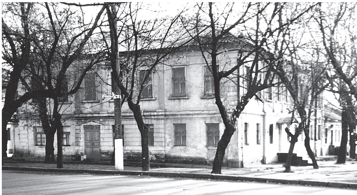
Дом училища Ф. Вулих на пересечении ул. Никольской и Глазенаповской
